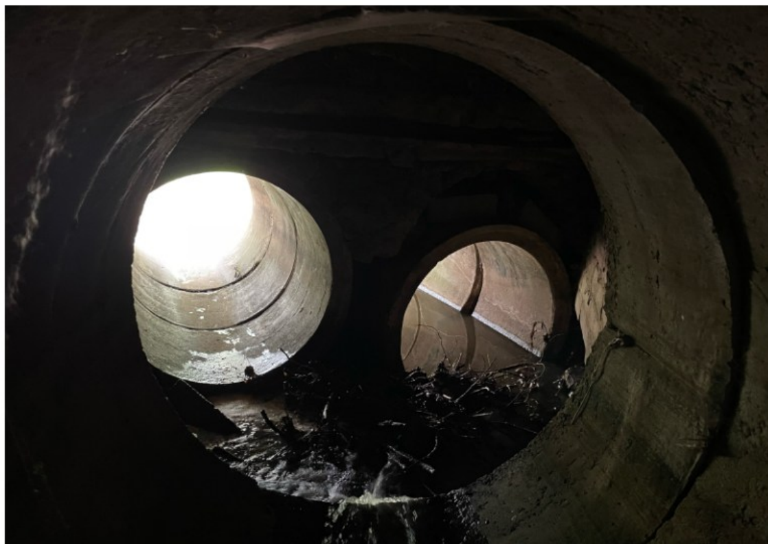
Fot. 2. Przepust drogowy wzdłuż ul. Repeckiej. W końcowym fragmencie jedna rura rozdziela się na dwie o mniejszej średnicy. Widoczny nabierany przy niżówce rumosz, przy wyższych przepływach miejsce to bezpośrednio stwarza zagrożenie powodziowe powyżej, ekstremalnie narażone na zatykanie. Również stan rur i ich średnica pozostawiają wiele do życzenia.
