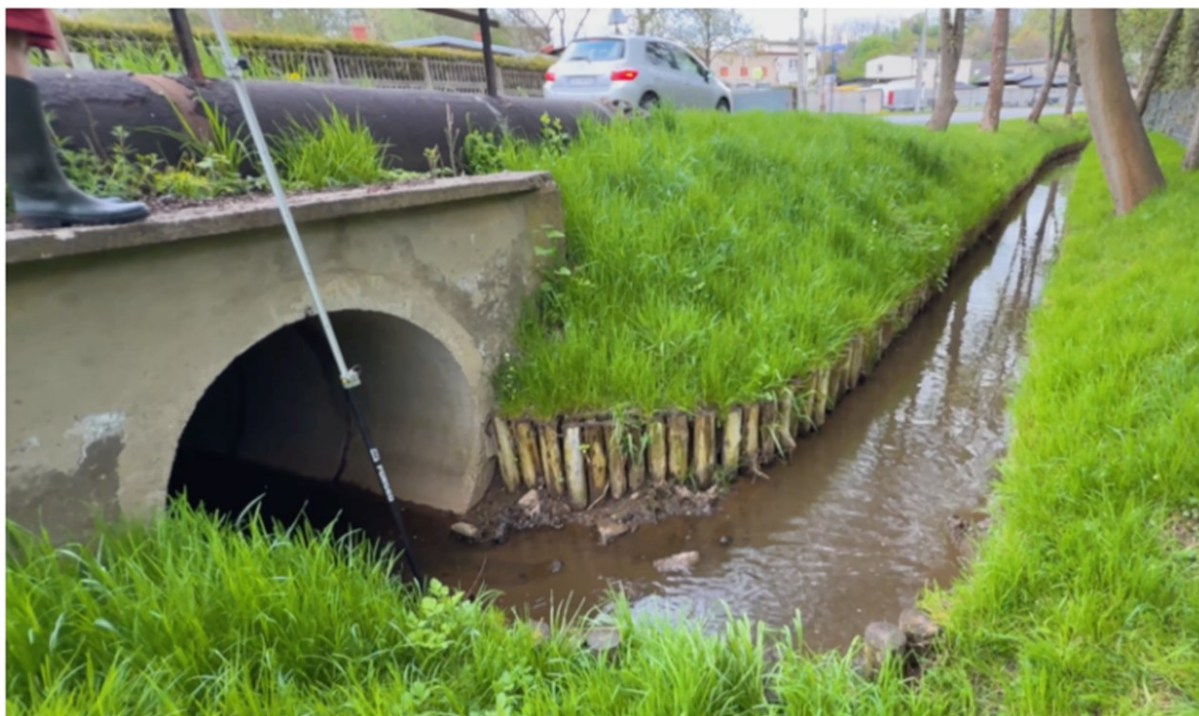
Fot. 1. Przepust drogowy pod ul. Witosa. Ustawienie wlotu przepustu pod kątem prostym do koryta powyżej naraża ten obiekt na zmniejszenie przepustowości przez zatkanie rumoszem drzewnym i śmieciami (a w konsekwencji spowolnieniem prędkości przepływu powyżej).
